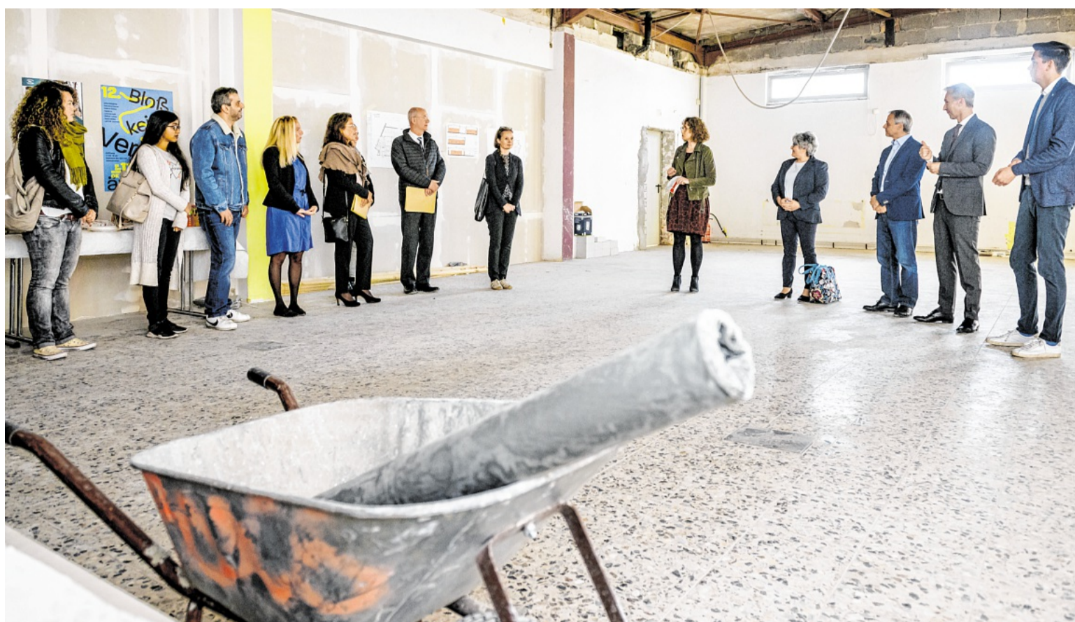
Alle Beteiligten kamen zum Baubeginn in die Räume an der Bochumer Straße in Ückendorf.
